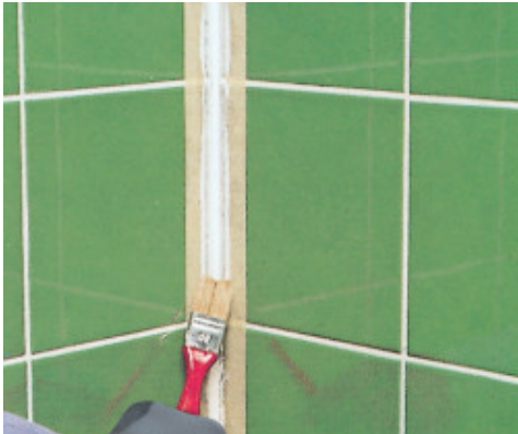
Glatting av fugen med såpevann og en liten kost
