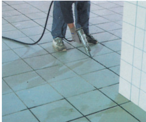
Fuging av keramiske gulvfliser med Mapesil AC
